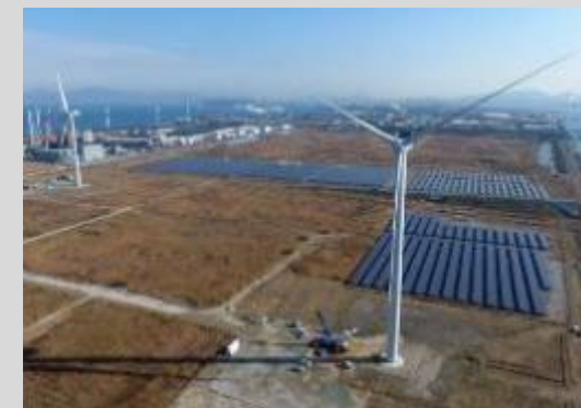
響灘 (9.6MW※太陽光と風力の合計)
